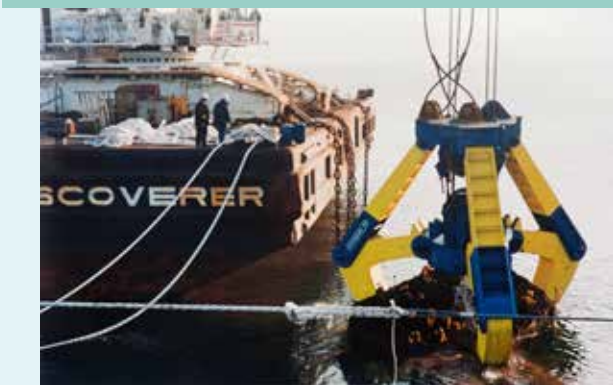
Cimentaciones eólicas offshore .
