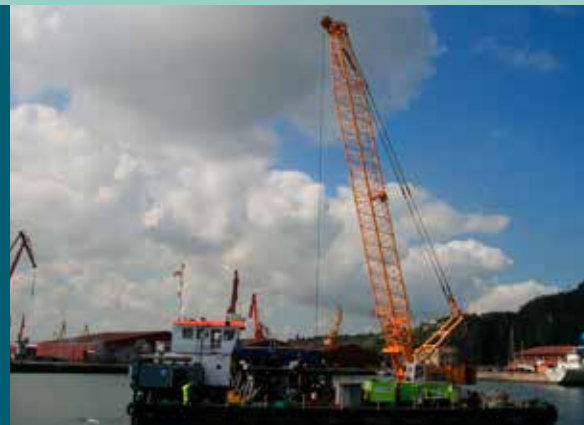
Pontona SATO Algeciras.
