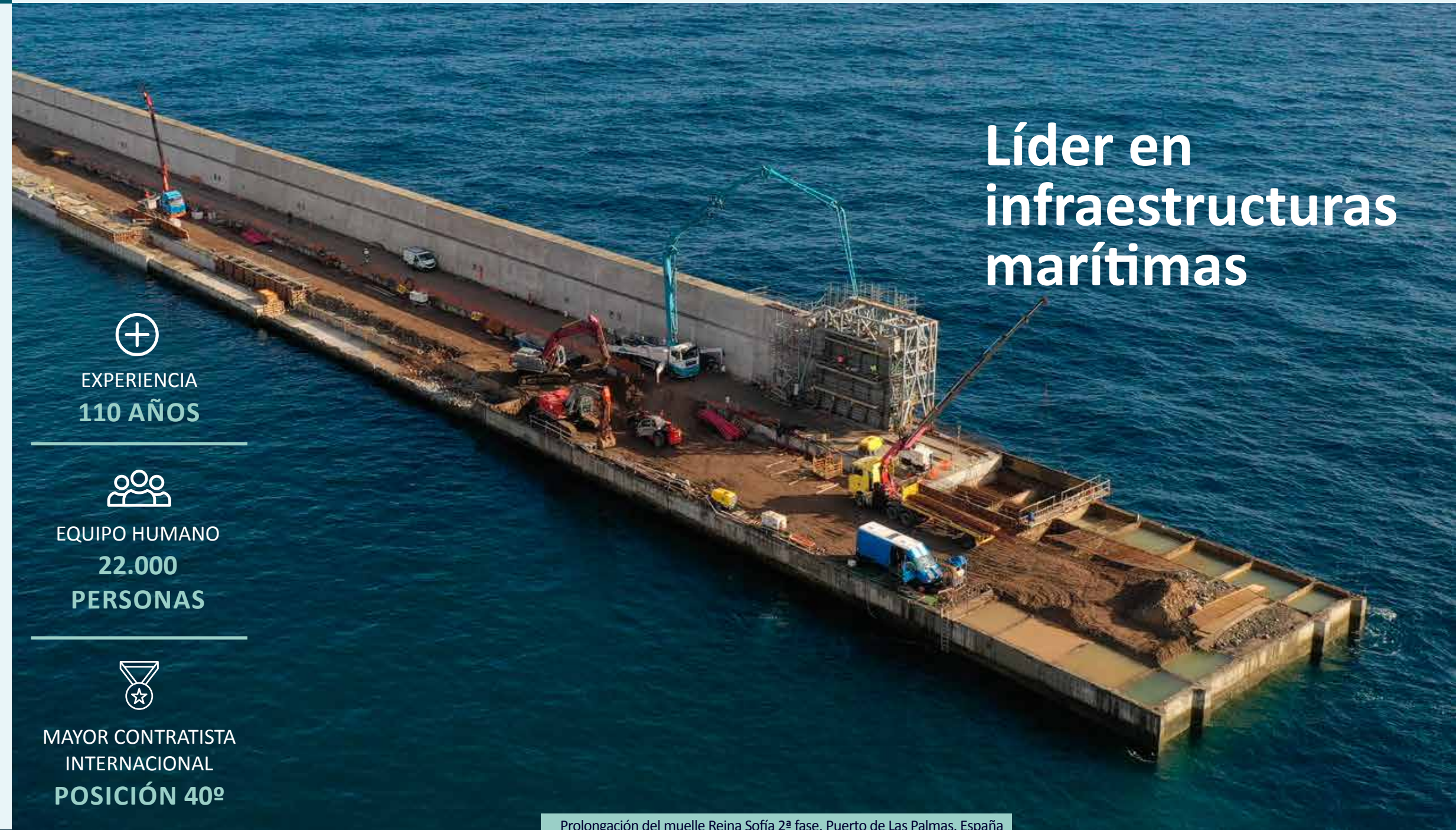
Prolongación del muelle Reina Sofía 2ª fase. Puerto de Las Palmas. España
