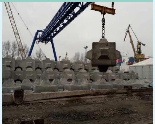
Fabricación de Cubipod.
